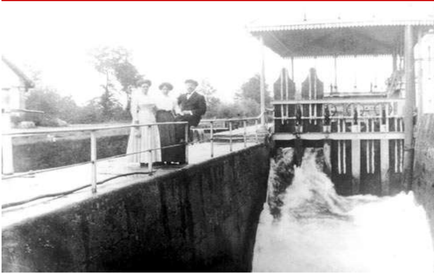
La conca sul Naviglio di Pavia, all'altezza della Filatura De Shappe. Foto degli Anni '20
