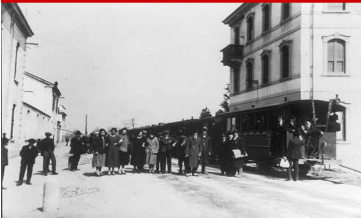
Il "Gamba de' legn" sulla Pavese all'altezza della Filatura de Schappe 1925
